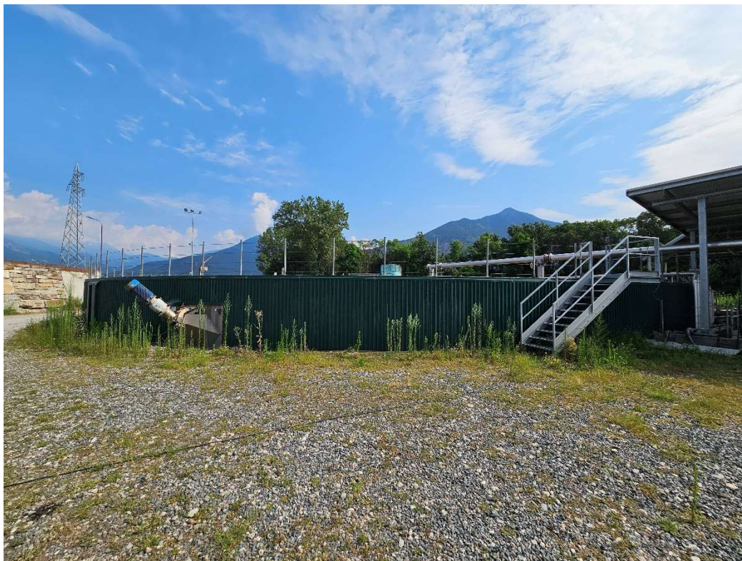
Fotografia 5: Digestori primario e secondario solettati DG1 e DG2.
