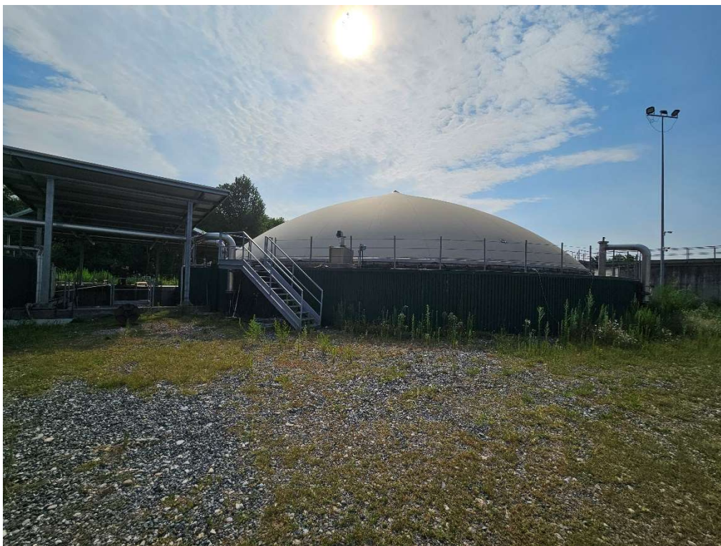
Fotografia 7: Vasca stoccaggio coperta con recupero di gas e copertura gasometrica VD1.
